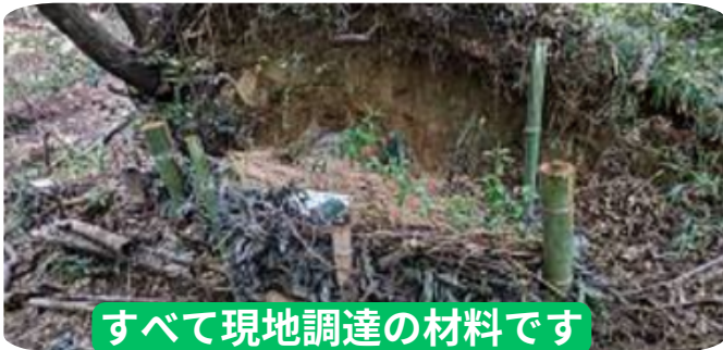
崩れた斜面にしがらみ棚をつくる
